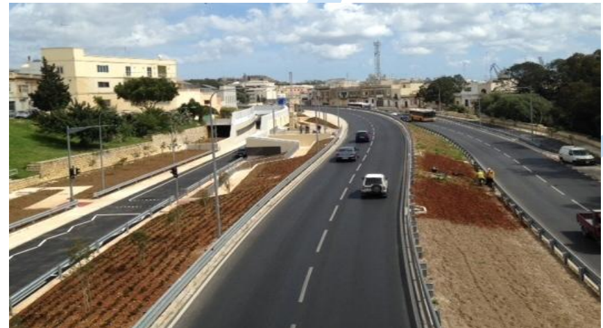
Phase I: Marsa underpass and Dicembru 13 Road
